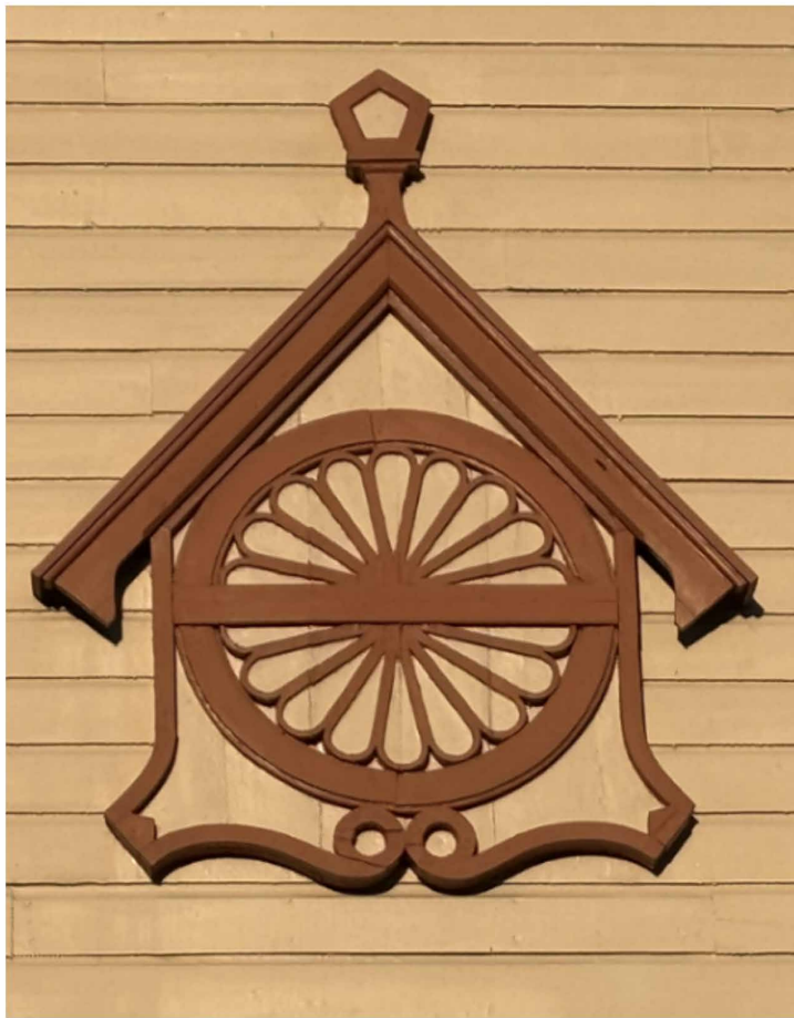
Kuva 2. Rauman kampuksen Kirjastorakennuksen koristekuvio
