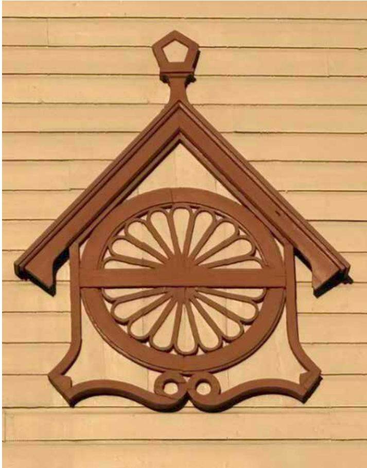
Kuva 2. Rauman kampuksen Kirjastorakennuksen koristekuvio
