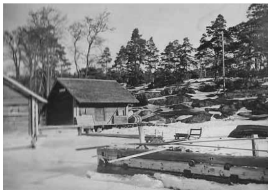
Ranta-aitta sijaitsi aikaisemmin kiinteästi laiturin yhteydessä. Rakennusta siirrettiin yhteysaluslaiturin rakennustyön ja rantakentän täytön yhteydessä vuosina 1998–1999. Etualalla nk. Aalopin korjaustyömaa. Aallonmurtajaan kiinnitettiin pieniä veneitäkin silloin kun laiturissa ei ollut tilaa. Tämä kevättalvinen kuva on 1930-luvulta. Holländerien kuvakansio, Pro Seili-Själö ry:n valokuva-arkisto
