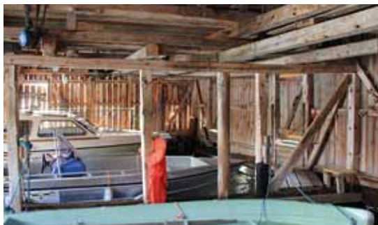
Laajarunkoinen lautavaja rakennettiin isomman aluskannan tarpeisiin. Vahvistetut kattorakenteet mahdollistavat useiden veneiden noston taljojen varaan talvikausiksi. Kuva: Totti Tuhkanen 2011
