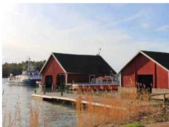
Postirannan venevajat saivat uuden maalipinnan vuonna 2010. Etualan laituri ulottuu vanhan aallonmurtajan kiviarkun yli. Kuva: Tuija Tuhkanen 2011
