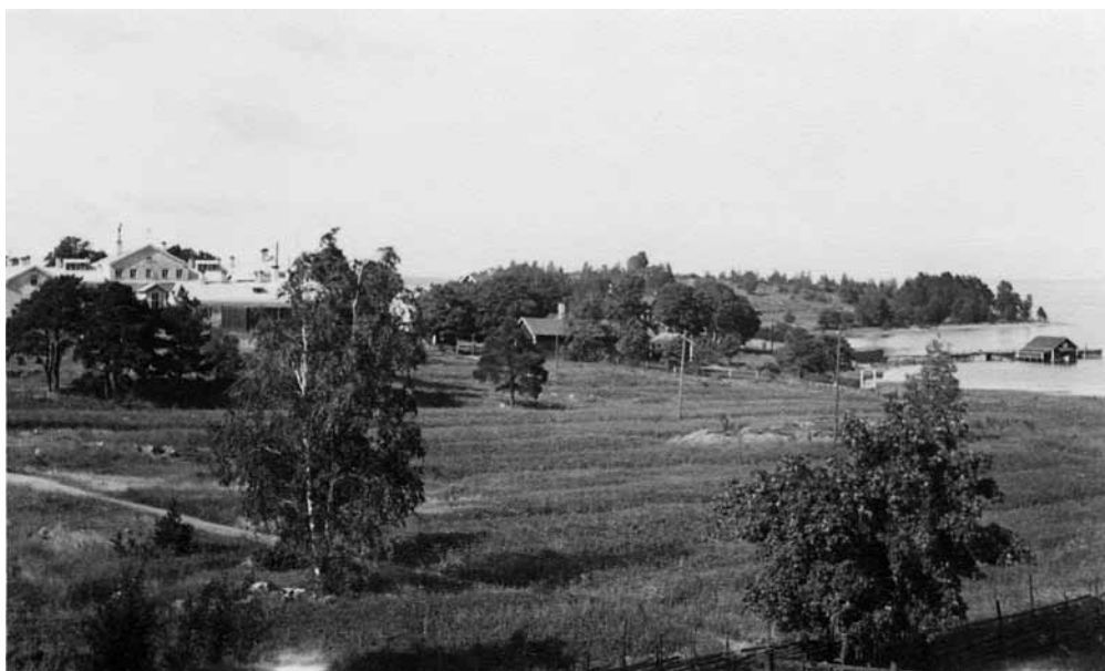
Sairaalan rantaan Lembergsvikenille saatiin 1930-luvulla sisäministeriön myötävaikutuksella kruununmakasiinin hirsistä rakennettu venevaja. Rannan puoleisella seinustalla on nähtävissä pieni pulpettikattoinen lisärakennus Erik Malmin veneelle.
