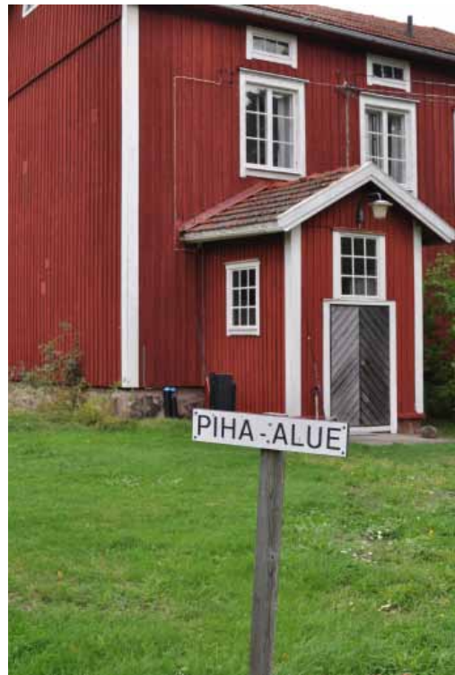
Kuva 23. Luonto- ja kulttuuriarvoiltaan rikkaassa vanhan mielisairaalan ja hospitaalin ympäristössä sijaitsee myös useita Saaristomerén tutkimuslaitoksen tutkimus- ja majoitusrakennuksia. Mikko Helminen.
