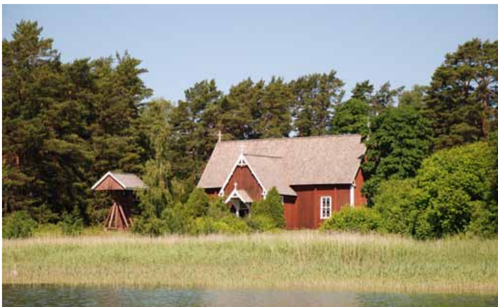
Kuva 25. Seilin nykyisin museokirkkona toimiva hospitalikirkko on rakennettu vuonna 1733. Nykyinen kellotapuli noudattaa pääpiirteissään nykyisen kirkon aikana samalla paikalla sijainnutta mallia. Juhana Ahlamo.
