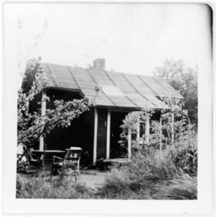
Pähkinämäki Katkurussa oli Ossianin vanhuudenkoti, jonka hän rakennutti poikansa ollessa sodassa.
