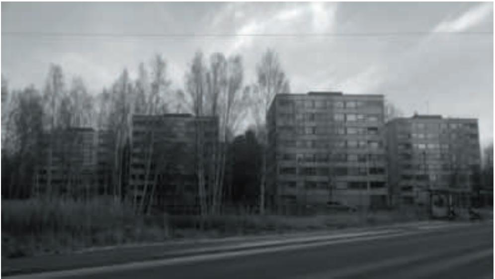
Kuva 6.3. Näkymä tien toiselta puolelta.
